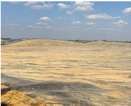
รูปที่ 2.8.2-3 สภาพของบ่อหมักไร้อากาศ 1 และ 2 หลังจากคลุมบ่อ ในช่วงที่มีปริมาณก๊าซในระบบเพิ่มขึ้น
