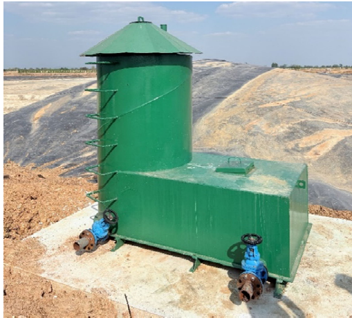
รูปที่ 2.8.2-1 ระบบกำจัดกลิ่นจากก๊าซไฮโดรเจนซัลไฟด์ ( H_2S ) ที่ติดตั้งบริเวณขอบบ่อ จำนวน 4 ชุด
