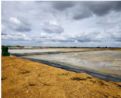
รูปที่ 2.8.2-2 สภาพของบ่อหมักไร้อากาศ 1 และ 2 หลังจากคลุมบ่อ ในช่วงที่ยังไม่เกิดก๊าซ
